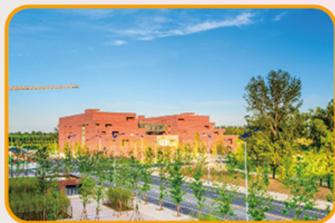
教学综合实验楼
